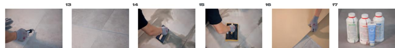
13- Antes de proceder al rejuntado, revisar que el material de agarre haya endurecido. Retirar los restos de crucetas, limpiar las juntas de colocación en toda su longitud, anchura y profundidad y finalmente, comprobar que no quede humedad en el interior de la junta.
