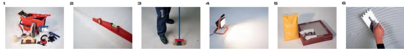
1- La colocación de cerámica requiere de personal cualificado, con experiencia demostrada y herramientas y útiles adecuados: llanas dentadas, crucetas, mazas de goma, ventosas para la colocación y llanas de goma, esponjas y cubetas para el rejuntado. Revisar previamente la información contenida en los embalajes y respetar escrupulosamente las recomendaciones del fabricante.
