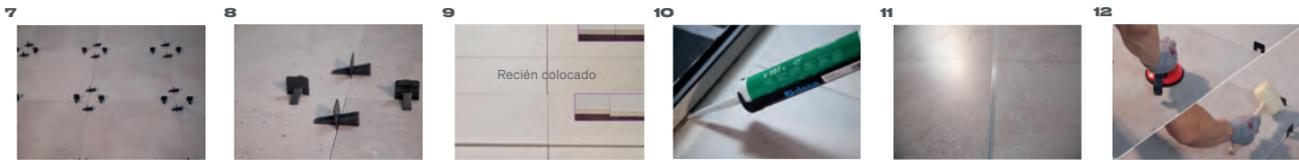
7- Todas las baldosas cerámicas y en especial las rectificadas, deben manipularse con el máximo cuidado, para evitar su rayado, despuntado o desconchado. Antes de iniciar la colocación, comprobar que la baldosa no presente ningún defecto.
